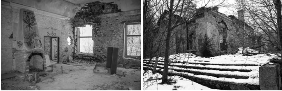
Po lewej sala balowa dworku, stan 2012 r. Po prawej widok części dworku z salą, 2021 r. Fot. Autora.
