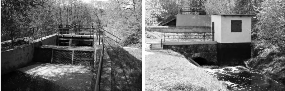
Jaz i budynek elektrowni obecnie. Fot. autora.
