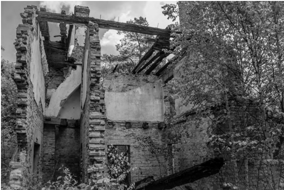
Zrujnowane wnętrze dworku obecnie. Fot. autora.
