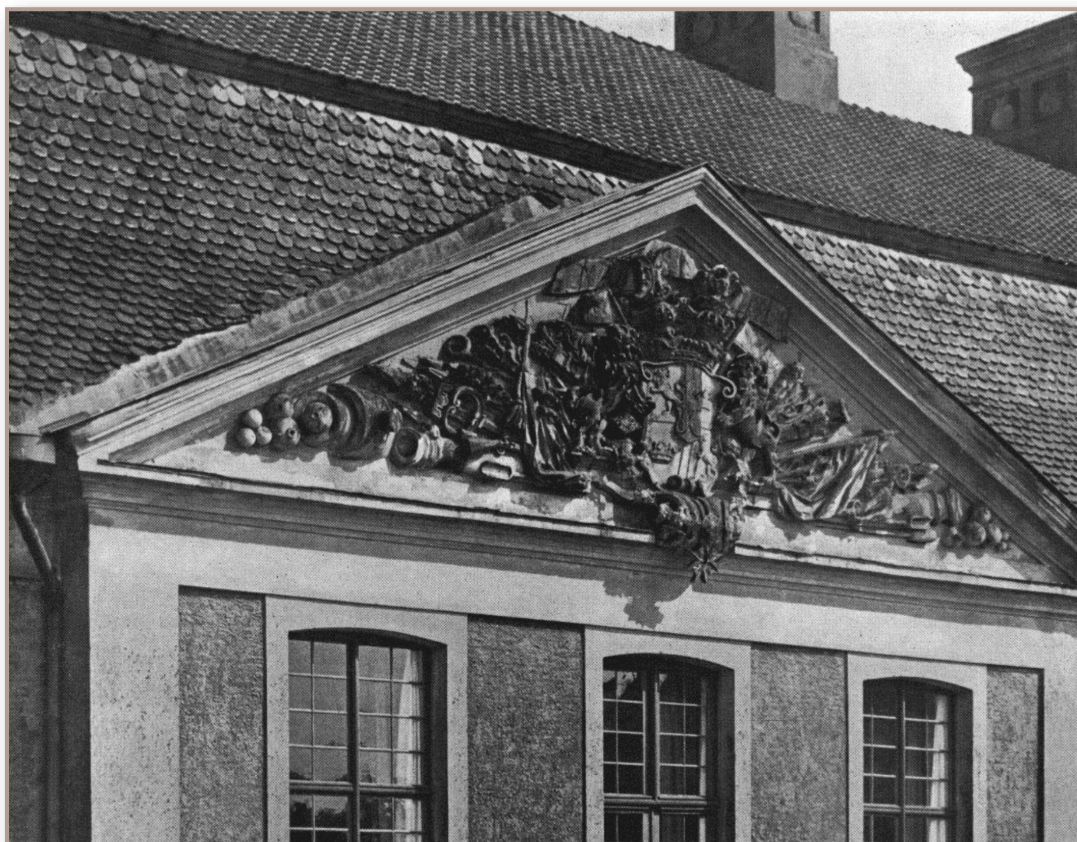
Tympanon elewacji frontowej pałacu z widocznym herbem
