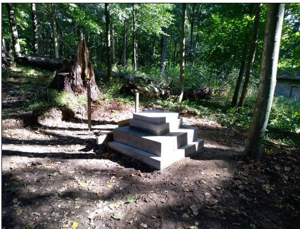
Fot.12 – dolna część pomnika tuż po zamontowaniu 22.09.2018r.
