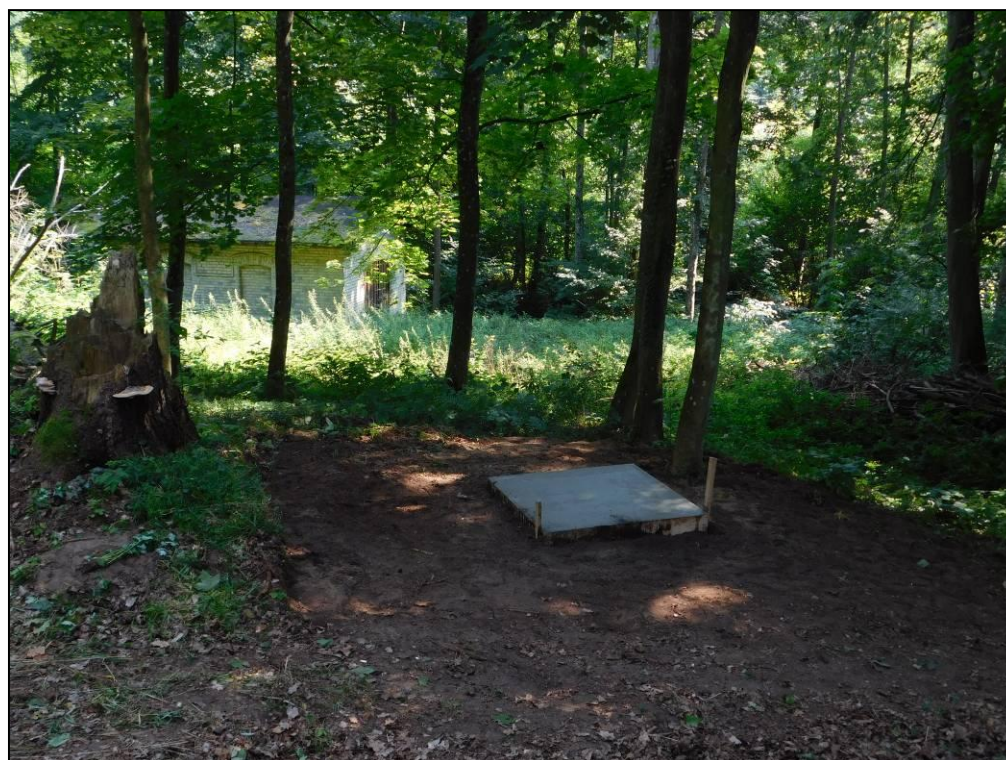
Fot. 7 – zdjęcie po zalaniu fundamentu w wykonanym wykopie i rozplantowaniu ziemi
